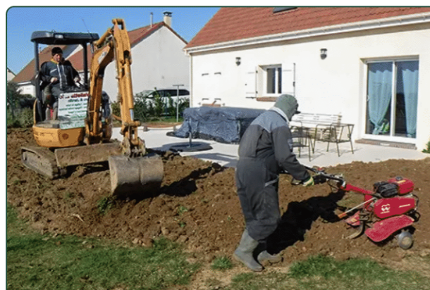
Chantier de terrassement
