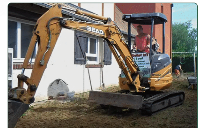
Usage de la mini-pelle sur un chantier
