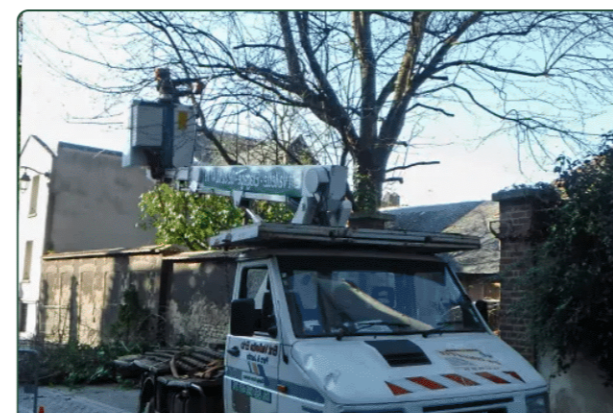
Elagage d'un arbre depuis la nacelle
