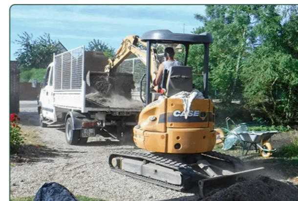
Usage de la mini-pelle sur un chantier
